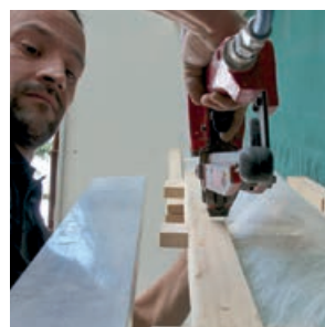
3. Fixation du montant extérieur
