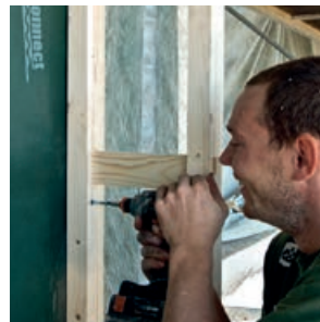
3. Fixation du montant extérieur
