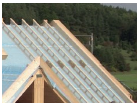
Contre-chevrons sur nouvelle toiture en pente
