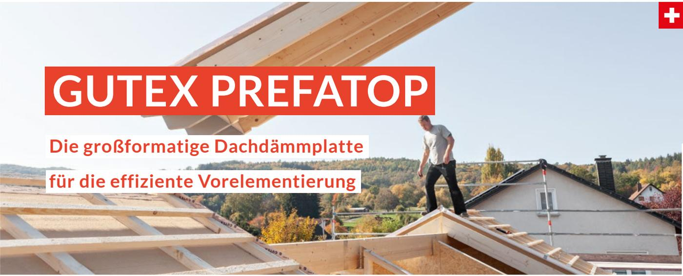
Durch den Einsatz von GUTEX Prefatop erhöhen Sie die Effizienz und den Ausstoß Ihrer Dachelement-Vorfertigung. Mit einer Länge von 2,50 m können Sie die Breite eines Dachelements mit nur einer Unterdachplatte auslegen. So erzeugen Sie ein dämmendes und regensicheres Unterdach in nur einem Arbeitsgang – ohne Verwendung einer Unterdachbahn.
