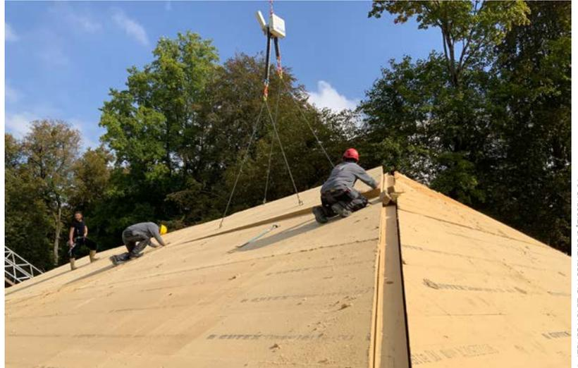
Auf der GUTEX Aufsparrendämmung mit Konterlattung und Lattung wurden 70 Prozent der alten Dachziegel wiederverwendet. Die diffusionsoffene, feuchteregulierende sowie winddichtende GUTEX Holzfaserdämmplatten DW besitzt eine hervorragende Wärmespeicherkapazität.
