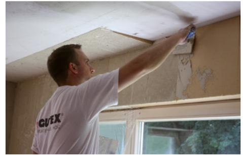
Enduire le coin isolant pour l'isolation des flancs/ la surface murale.
