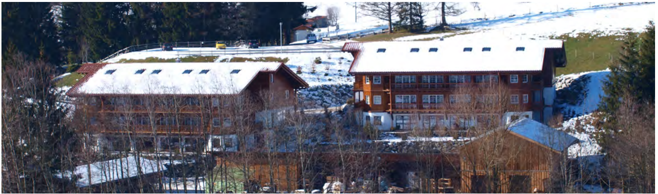
Abb. 5 Gesamtansicht Mitarbeiterhäuser Hotel Sonnenalp im Allgäu
