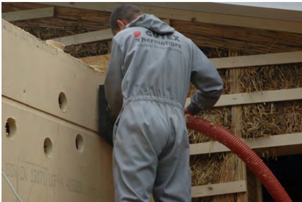
Abb 3. GUTEX Thermofibre Einblasdämmung aus Holzfasern wird in die Stegträger eingeblasen (Verbindungsbau.) (Quelle: Burg & Monjau)
