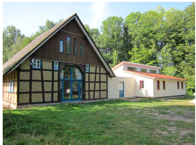
Abb 7. Frontansicht auf das sanierte Fachwerkhaus und den Neubau mit GUTEX Dämmung. (Quelle: Burg & Monjau)
