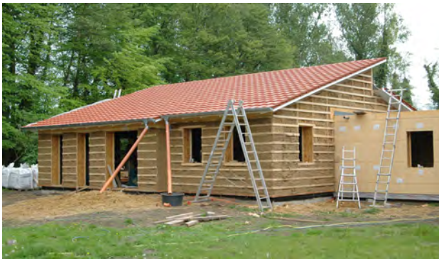
Abb 1. Neubau mit GUTEX Holzfaserdämmung und Strohballen mit Lehmputz. (Quelle: Burg & Monjau)
