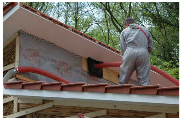
Abb 3. GUTEX Thermofibre Einblasdämmung aus Holzfasern wird in die Stegträger eingeblasen (Verbindungsbau.) (Quelle: Burg & Monjau)
