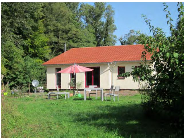
Abb 6. Sicht zum Garten zur Rückseite des Neubaus. (Quelle: Burg & Monjau)
