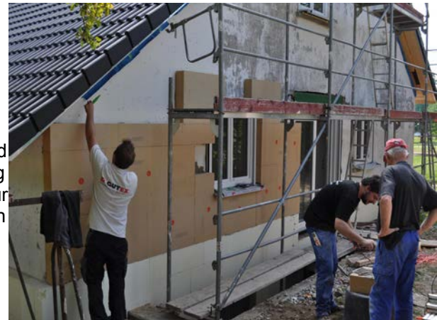
Abb 5. Fassadensanierung mit GUTEX Thermowall, Wärmedämmverbundsystem (Bild: GUTEX)
